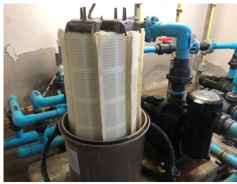
ระบบกรองน้ำสระว่ายน้ำ (ระบบเกลือ)
