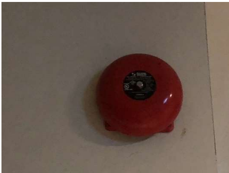
กริ่งส่งสัญญาณเตือนภัย
